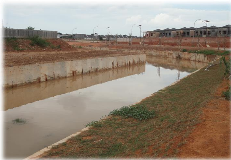
Gambar 2.4 Pembangunan Drainase Kota Batam
