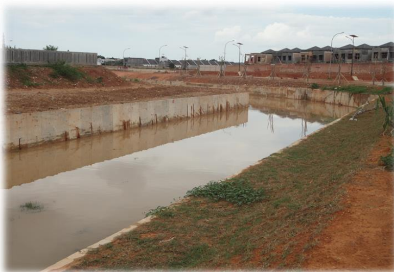
Gambar 2.4 Pembangunan Drainase Kota Batam
